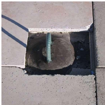
Suporte para instalação balancim
