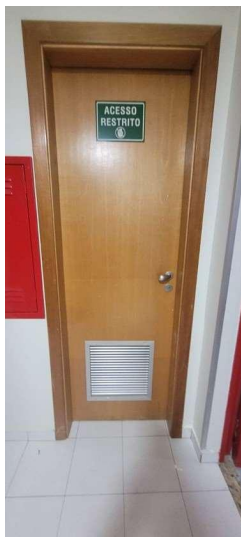
Detalhe porta acesso
