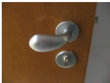
Detalhe fechadura banheiro
