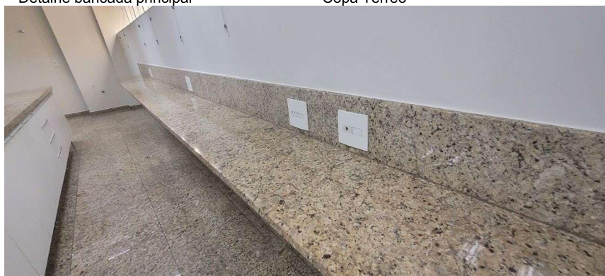
Detalhe bancada de apoio
