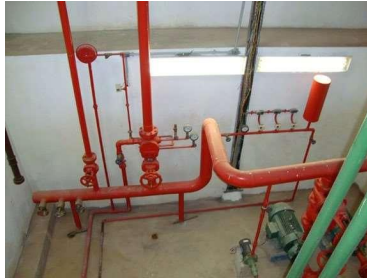
Detalhe quadro comando
