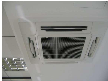
Detalhe evaporadora gesso
