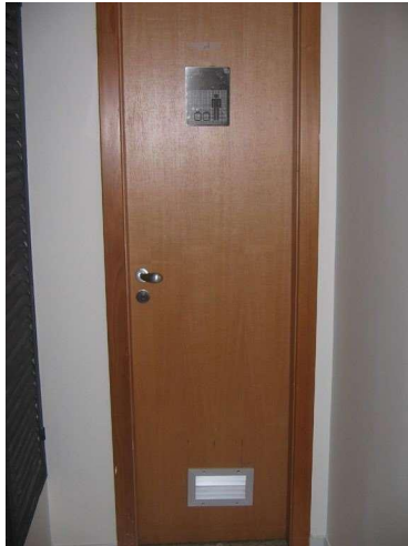
Detalhe porta acesso
