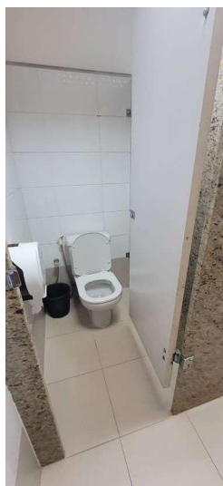
Detalhe box banheiro.
