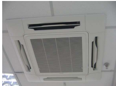
Detalhe evaporadora removível
