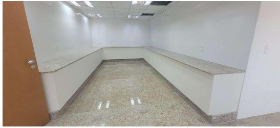
Bancada de aquecimento do refeitório
