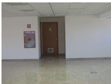
Detalhe acesso banheiros
